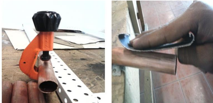
Figura 4.27 Corte y lijado de la tubería de cobre.
