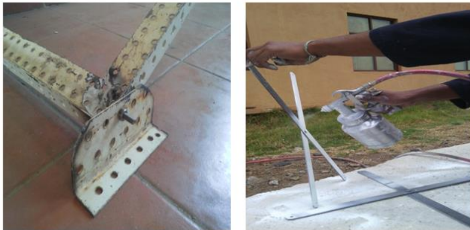
Figura 4.32 Soporte y pintado de la base.
