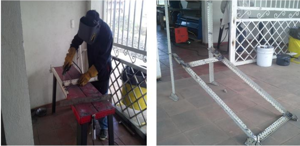
Figura 4.31 Soldadura de ángulo de acero.
