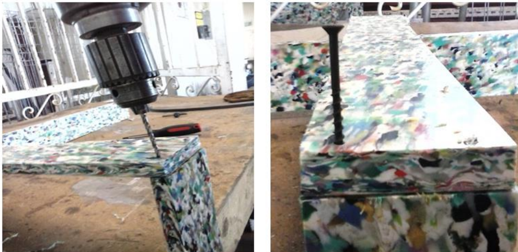
Figura 4.21 Perforación e inserción de pijas.
