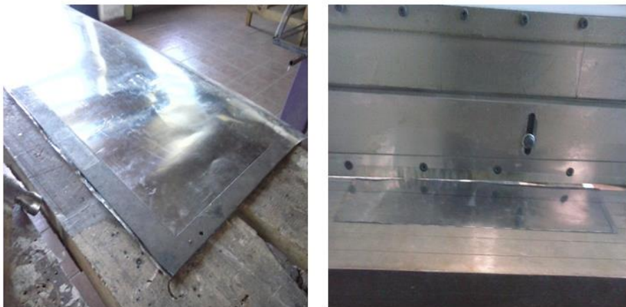
Figura 4.23 Medición y corte de lámina de acero inoxidable.
