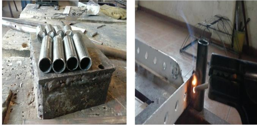
Figura 4.41 Corte y soldadura de tubular en la base.
