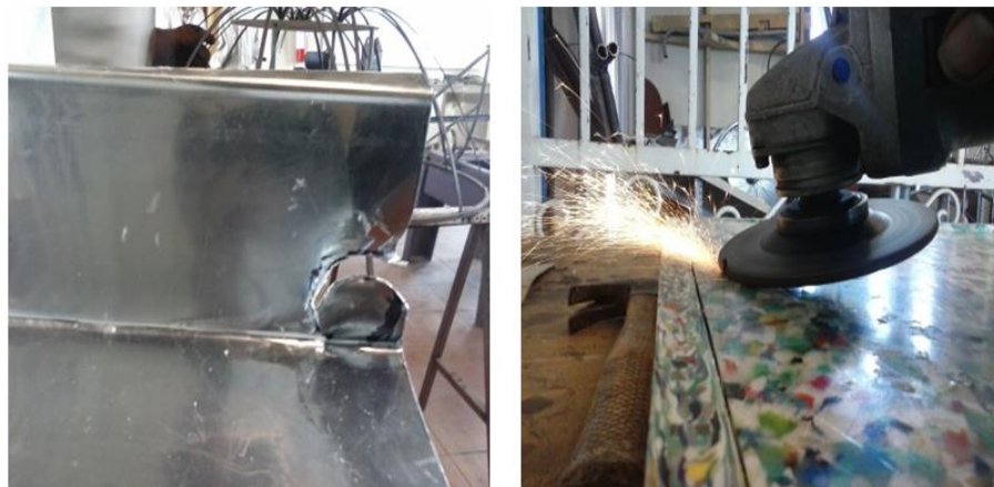
Figura 4.25 Perforación de lámina y esmerilado de sobrantes.
