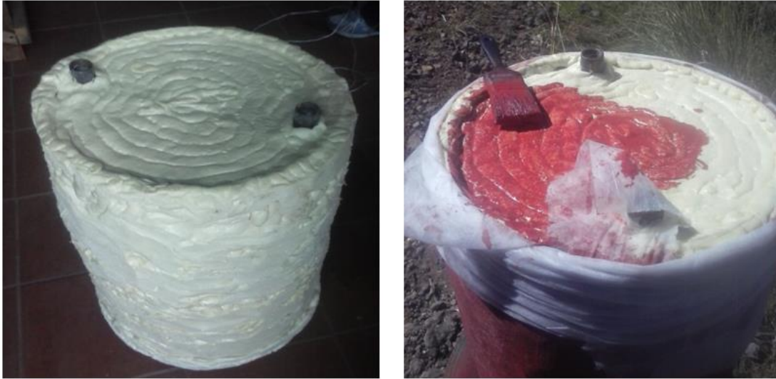
Figura 4.36 Aplicación de espuma y tela con impermeabilizante.
