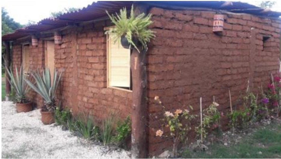
Figura 2.17. Casa construida con adobe y sargazo. Fuente: https://www.elfinanciero.com.mx/pyme/quintanarroense-construye-una-casa-con-tabiques-de-sargazo
