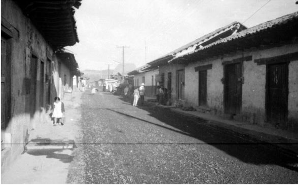
Figura 4. Pavimentación de la calle principal de Pichátaro
