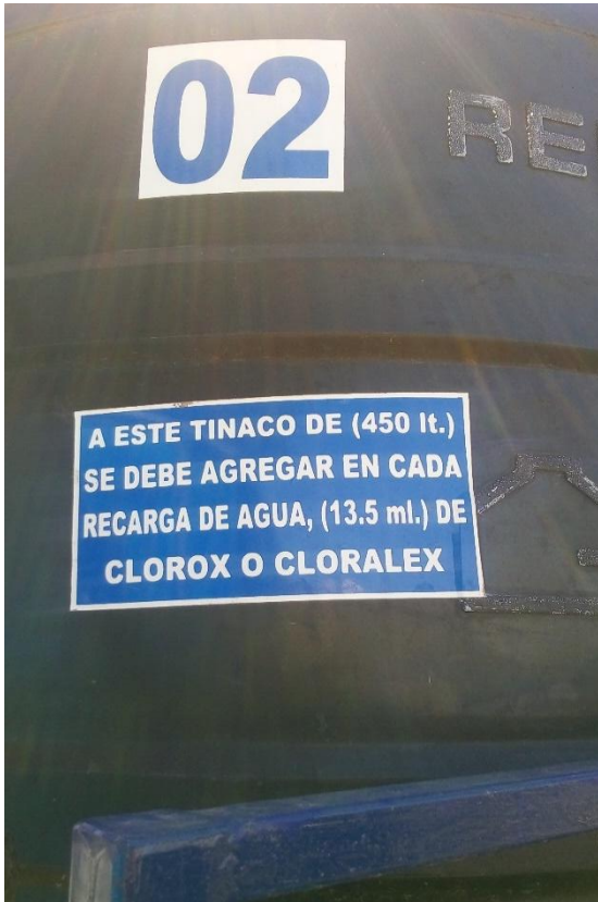
Figura 39.- Especificaciones para el agua en el tinaco para el lavado de manos.
